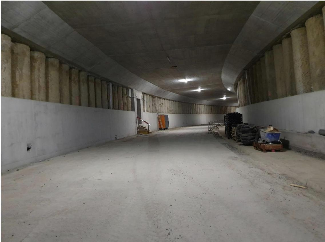
Tunnel nach Einbau Sohlspriessplatte und Anprallwand
