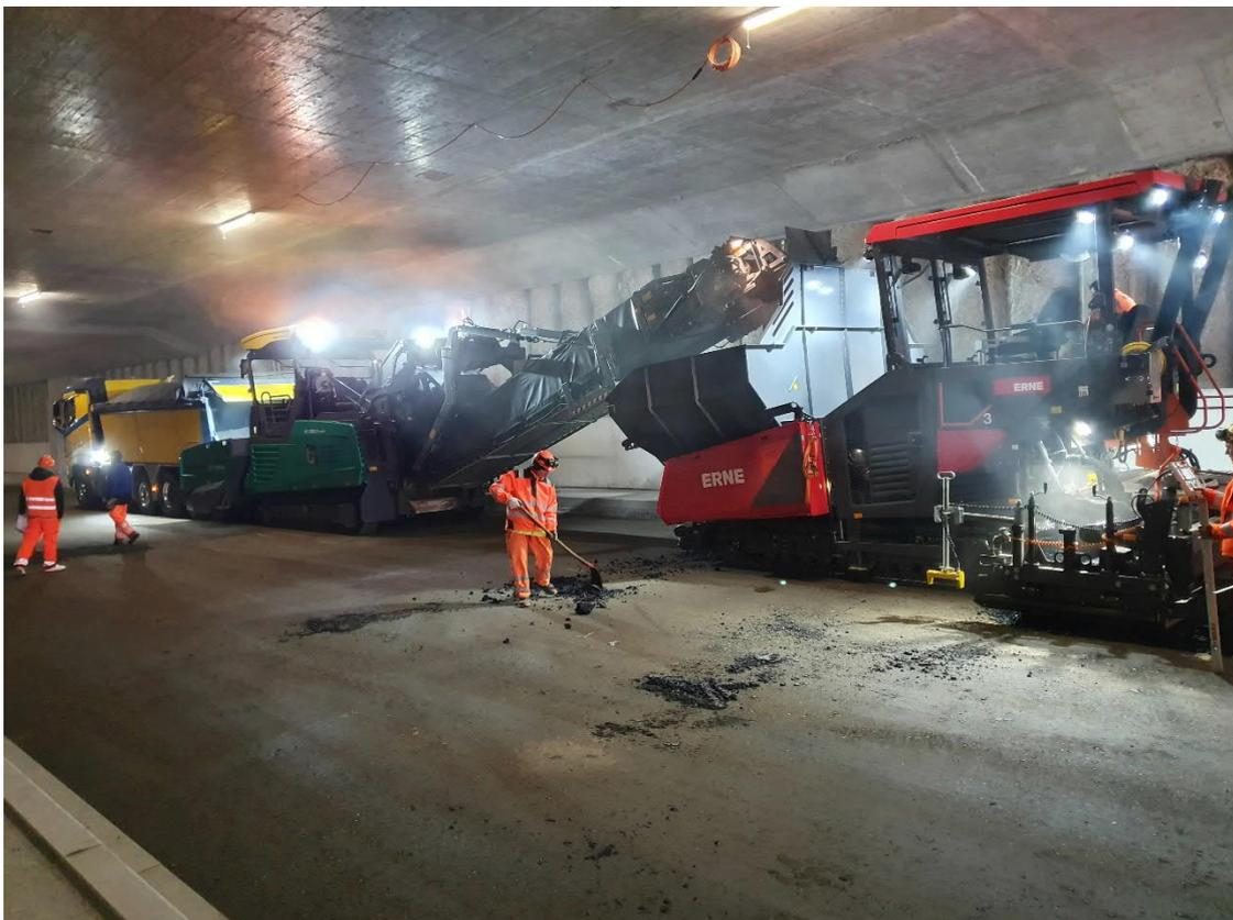
Einbau Tragschicht Tunnel mit Beschicker und Einbaufertiger
