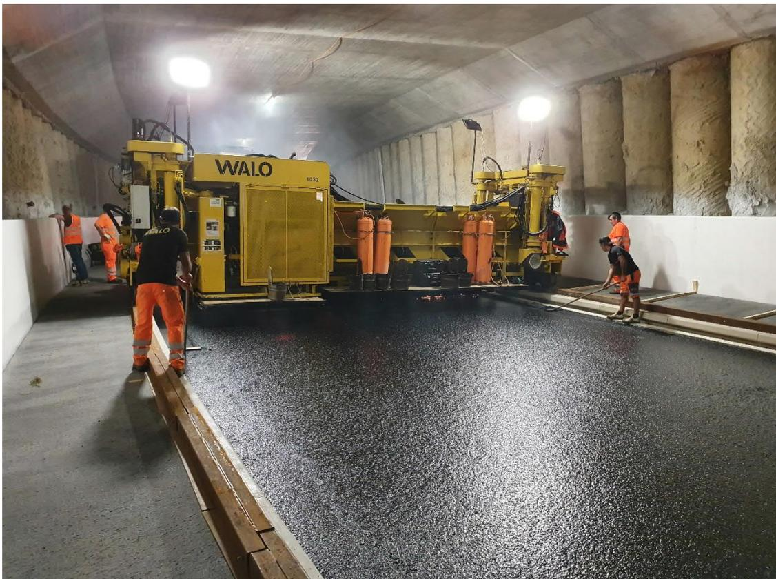
Einbau Gussasphalt Binderschicht
