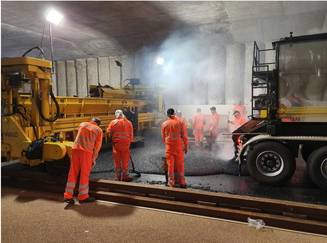
Einbau Gussasphalt Deckschicht
