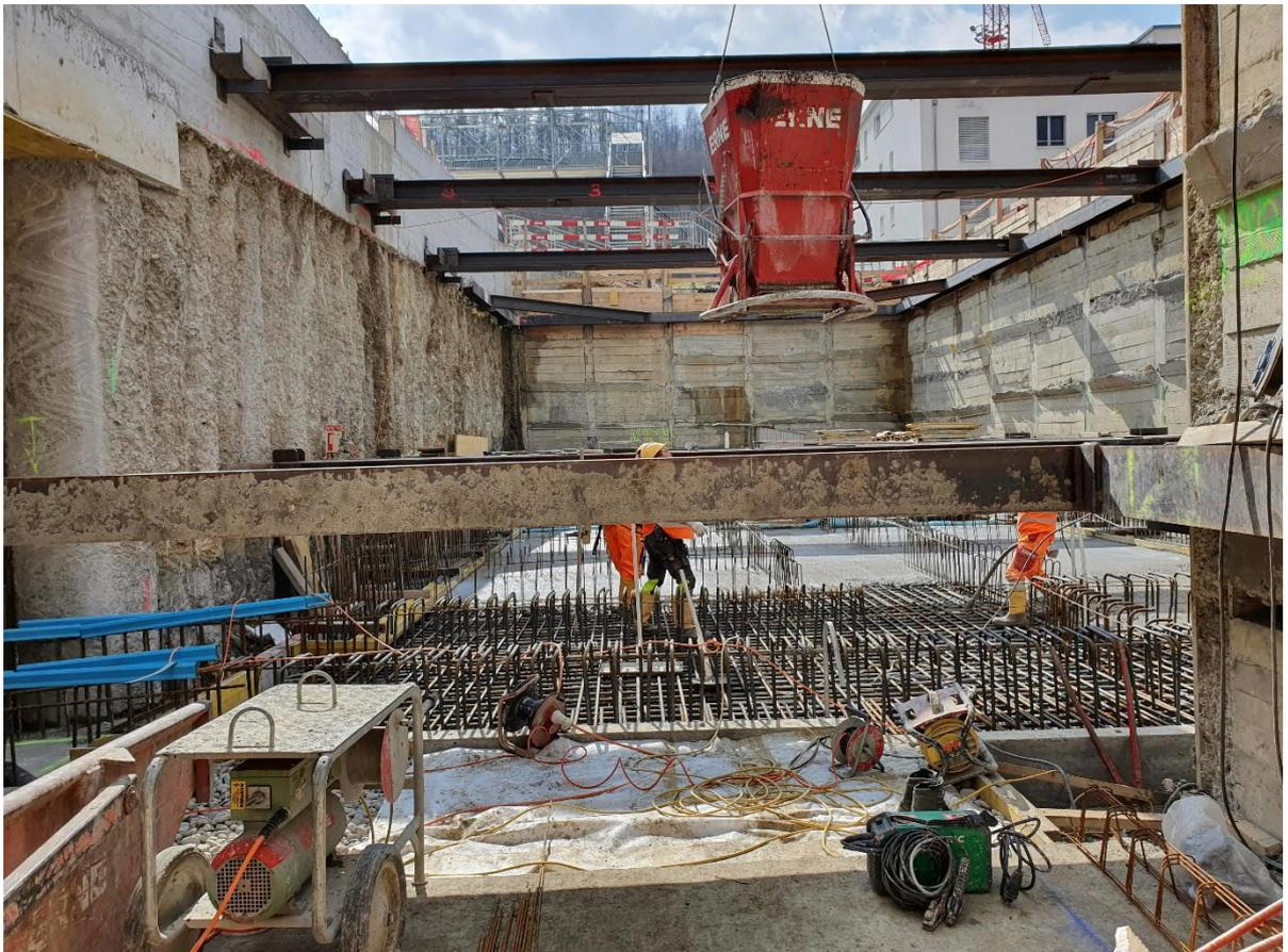
Betonieren Bodenplatte Zentrale in gespiesster Baugrube
