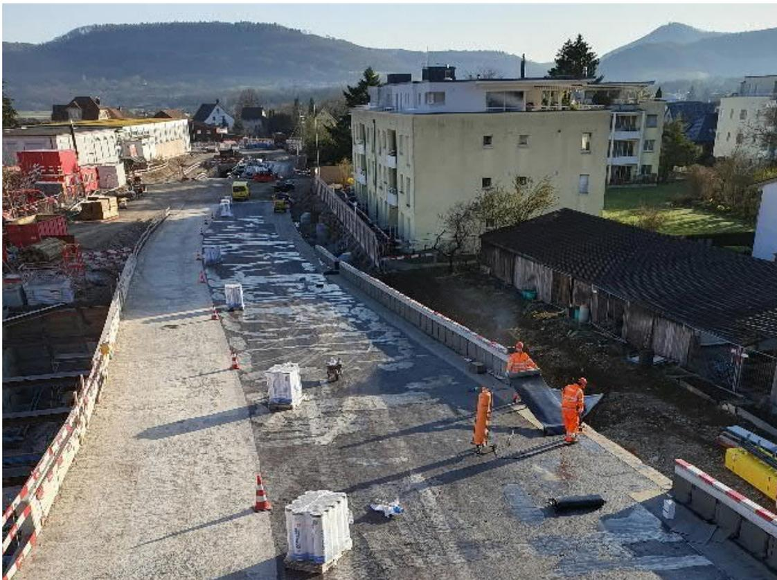
Abdichtungsarbeiten Tunneldecke Bereich südlicher Schützenweg
