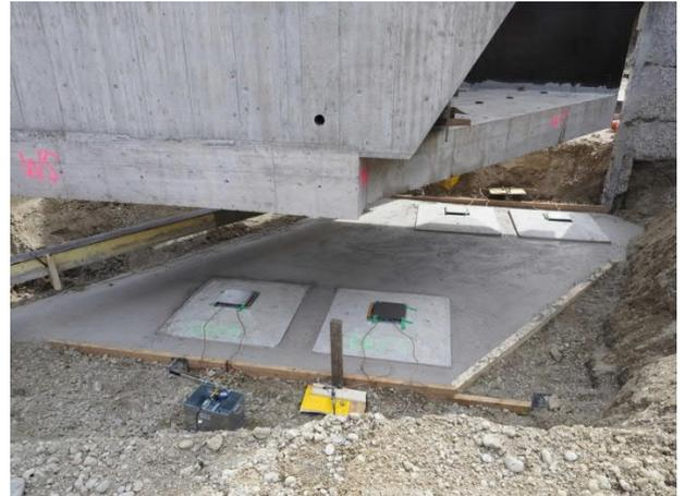
Versetzen Widerlager auf Nivellierfundamente
