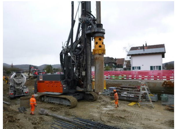
Ziehen Verrohrung Bohrpfahl
