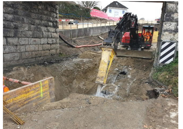
Abbruch alte Kanalisation unter SBB-Brücke
