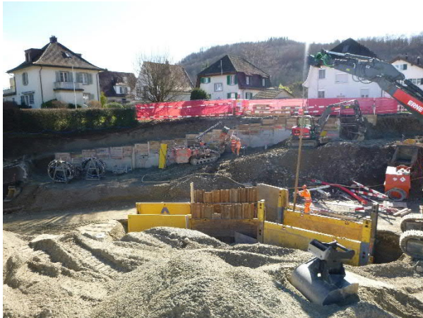
Baugrubenabschluss / Kanalisation
