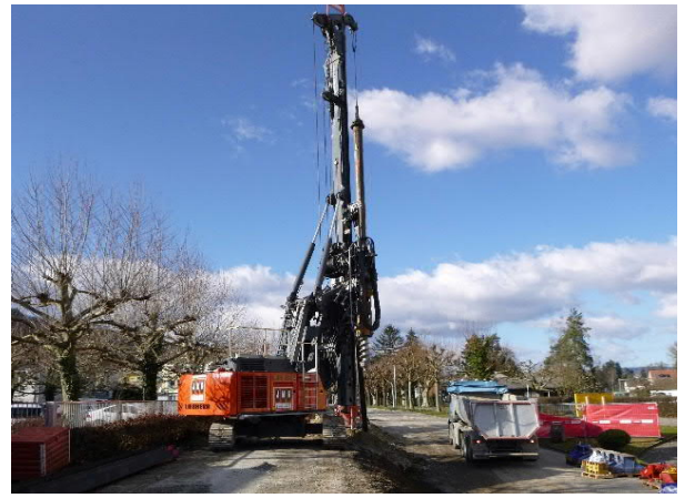
Bohrgerät Baugrubenabschluss
