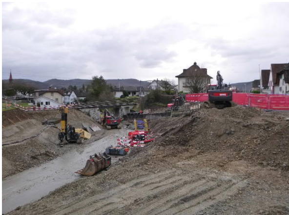
Baugrubenaushub Bereich Glockenstich
