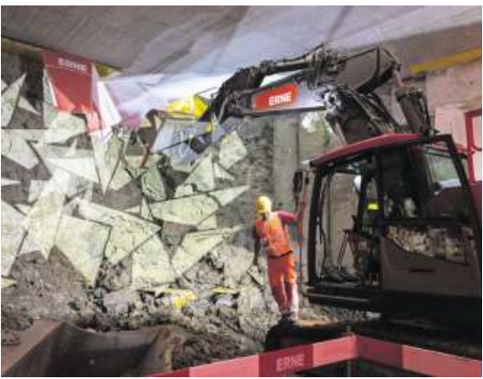
Imposant: Bagger bahnen sich die letzten Meter frei.
