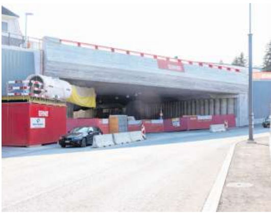
Die Tunneleinfahrt vom Grenzübergang her.
