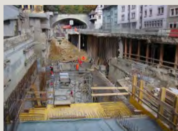
Erstellung des Bustunnels im Bereich «Falken» in Richtung Schlossbergtunnel.
