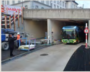
Meilenstein: Testfahrt im Bustunnel.
