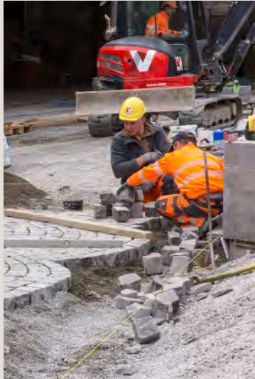
Verlegung der komplexen Natursteinpflasterung beim Cordulaplatz.
