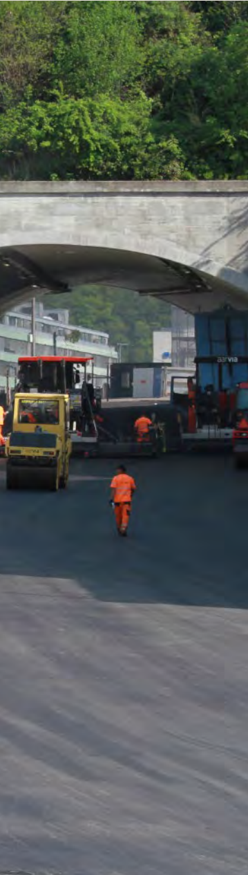
Belageinbau im Schlossbergtunnel.
