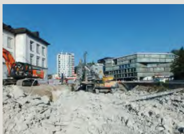
Die Baustelle im November 2015.
