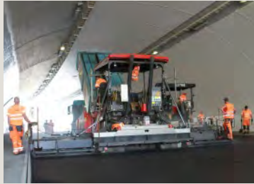
Belageinbau im Schlossbergtunnel.
