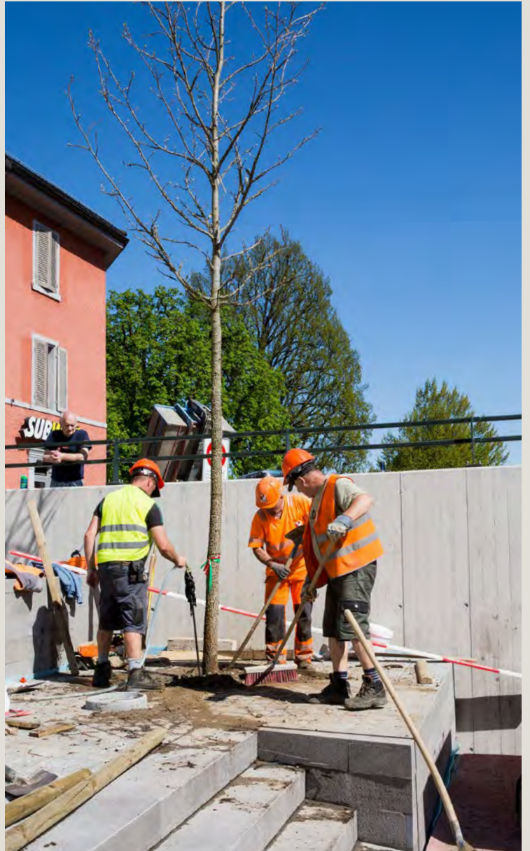
Begrünung des Zugangs zur Cordulapassage von der Weiten Gasse her.
