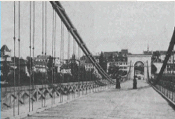
Aarebrücke Aarau, Kettenbrücke 1851 - 1949
