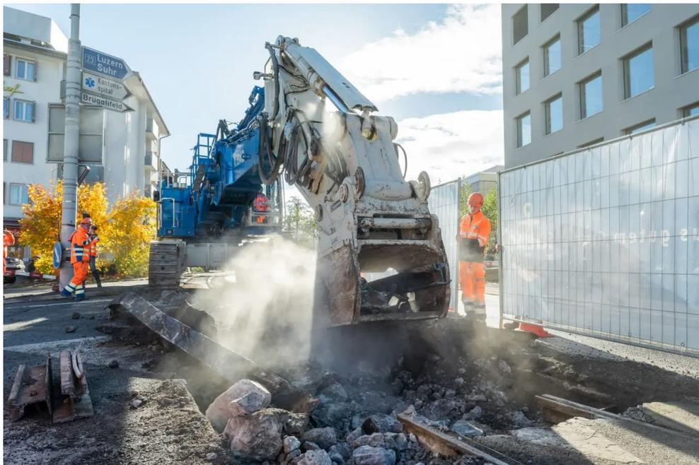
Die Kantonsstrasse wird saniert, ein Kreisel soll her. Im November wurden am Knoten Bavaria mit einem 190 Tonnen schweren Spezial-Bagger die Gleise entfernt.
