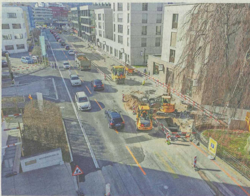
Die zweite Bauetappe (im Bild) steht kurz vor dem Abschluss. Die Bauphase 3 kann nächste Woche gestartet werden.
