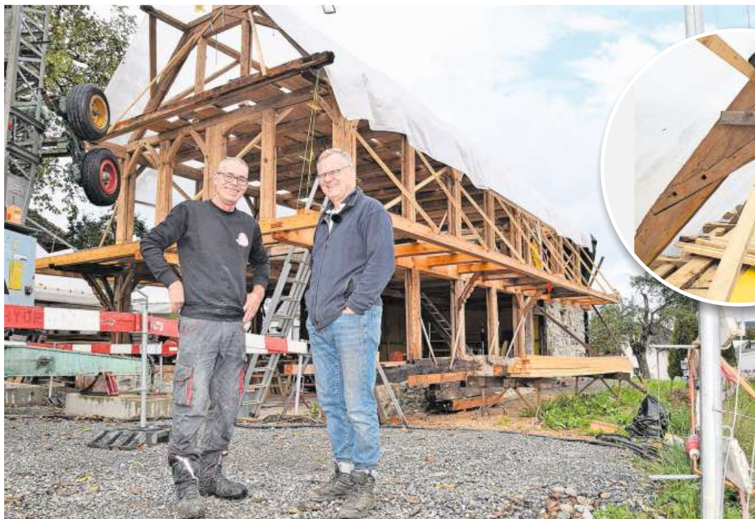
Bauherr Rolf Baumann (rechts), hier mit Dani Studer von Studer Bauservice, ist zufrieden mit den Arbeiten. Auch das Dachgeschoss (kleines Bild) wird ausgebaut.
