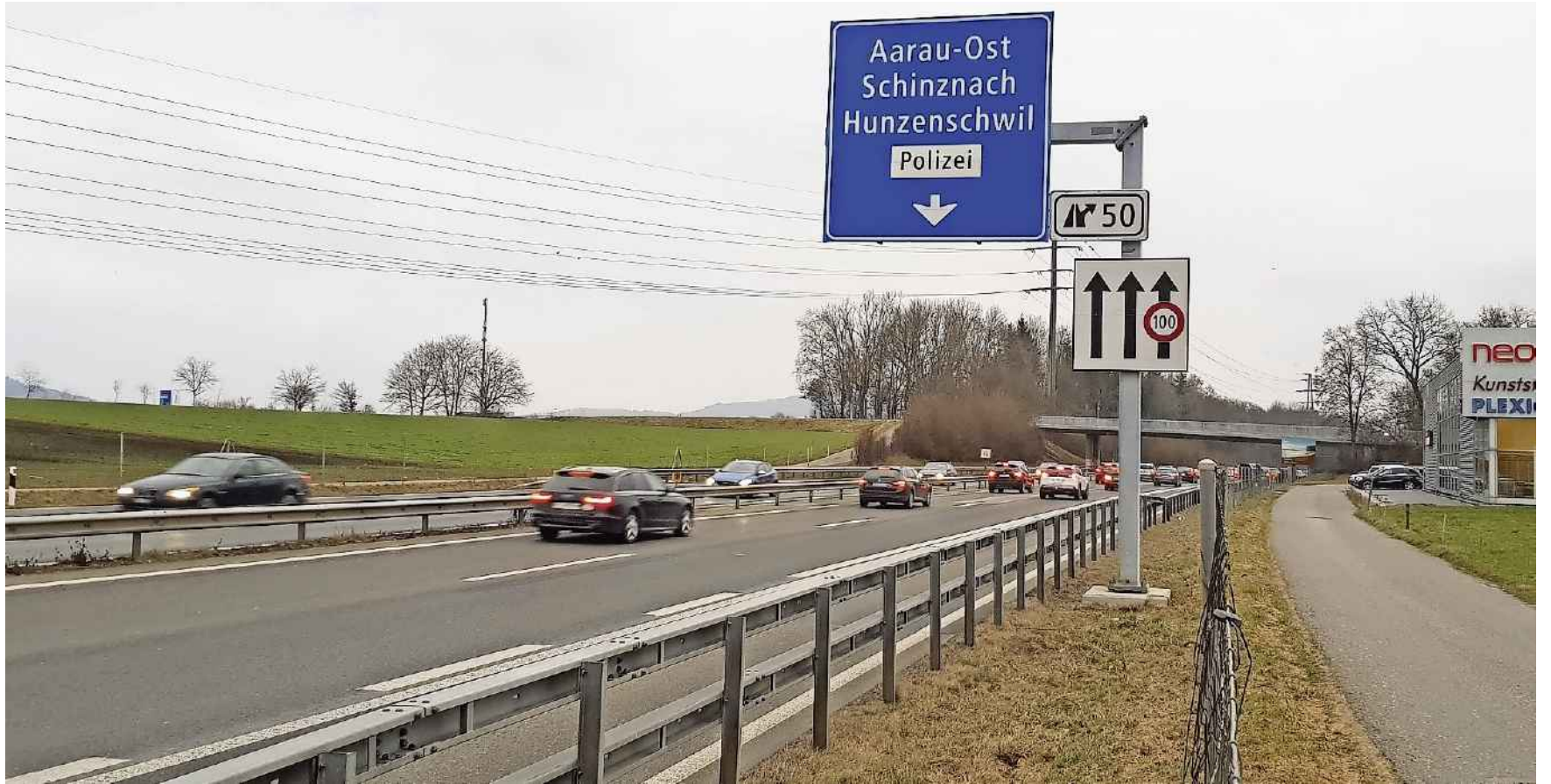
Da die A1 überlastet ist, wurden punktuell schon Pannestreifen zur zusätzlichen Spur umfunktioniert, wie hier vor der Ausfahrt Aarau-Ost.
