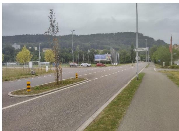
*Busspur vor Dosierungsanlage: Die Lichtsignalanlage ermöglicht das Zurückhalten des Staus ausserhalb des Siedlungsgebiets und die Priorisierung der Busse Richtung Baden.*
