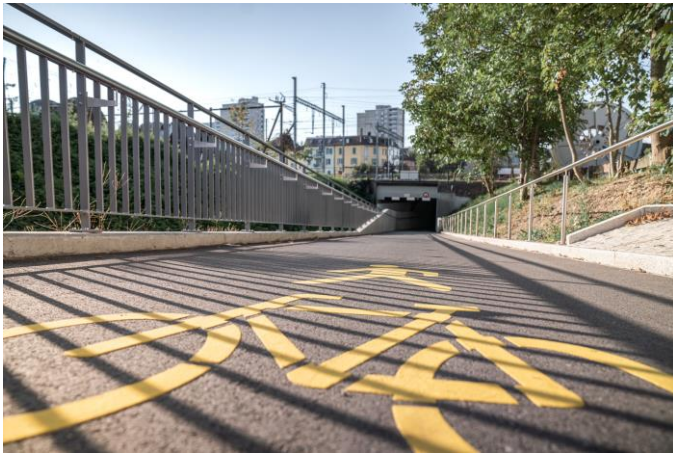
Süssbachunterführung / Foto: Steinmann Group
