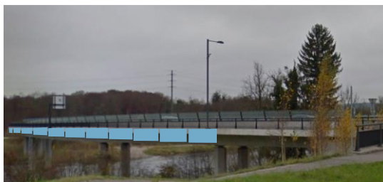
Abbildung 19 Skizze einer möglichen Anbringung von PV Modulen an der Seite (hier: nach Osten gerichtet) der Aarebrücke neue Staffeleggstrasse
