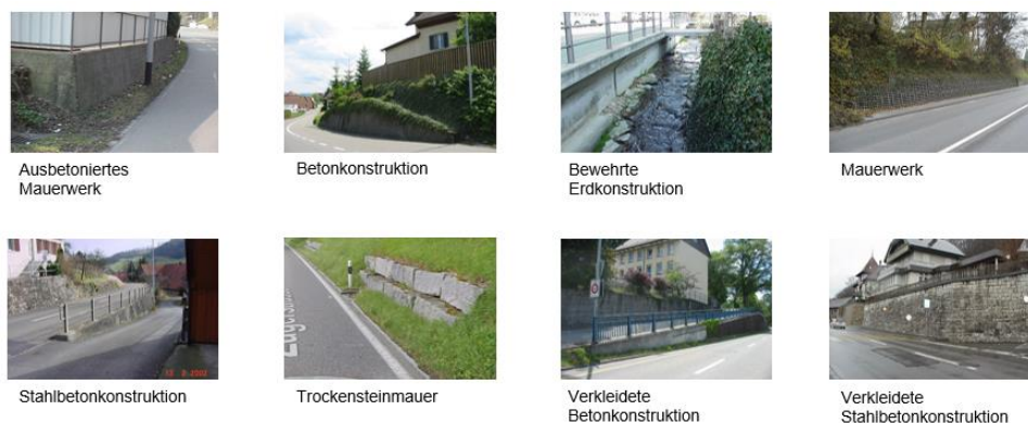
Abbildung 5 Beispiele verschiedener Stützmauerarten
