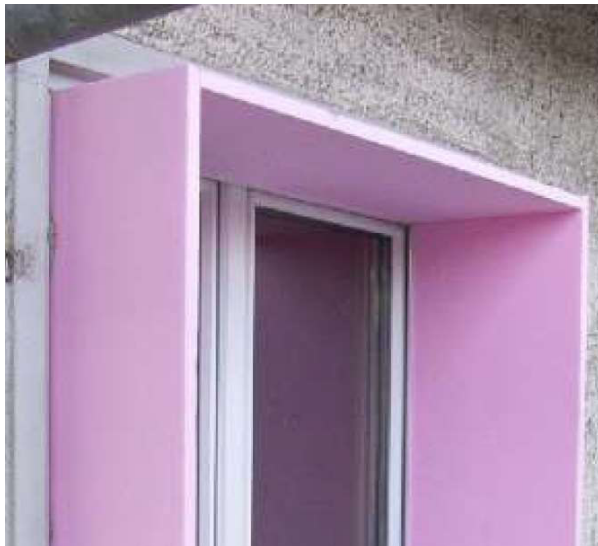
Abbildung 45: Leibungs- und Sturzdämmung [Quelle: BFE]
