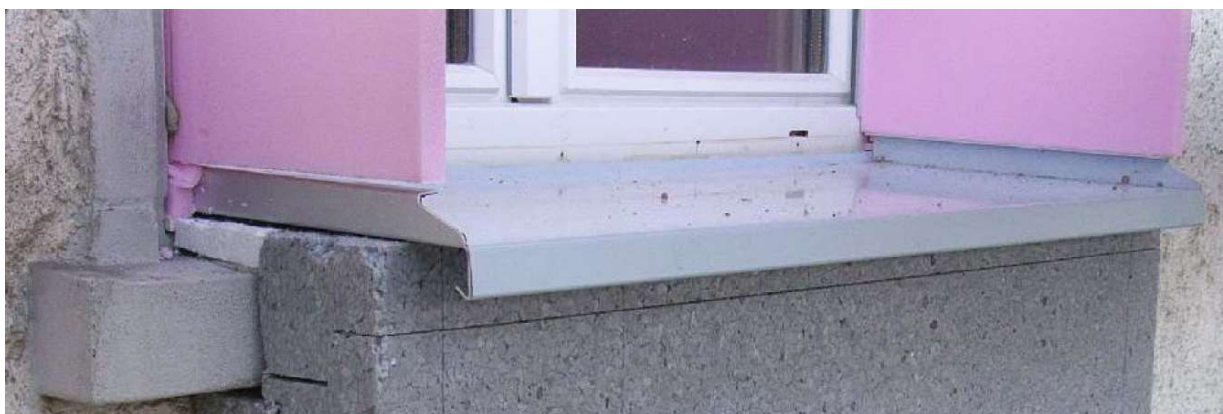
Abbildung 46: Dämmung im Simsbereich [Quelle: BFE]
