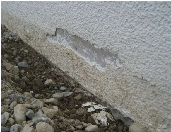
Abbildung 40: Schlechtes Sockelbeispiel [Quelle: B&E]
