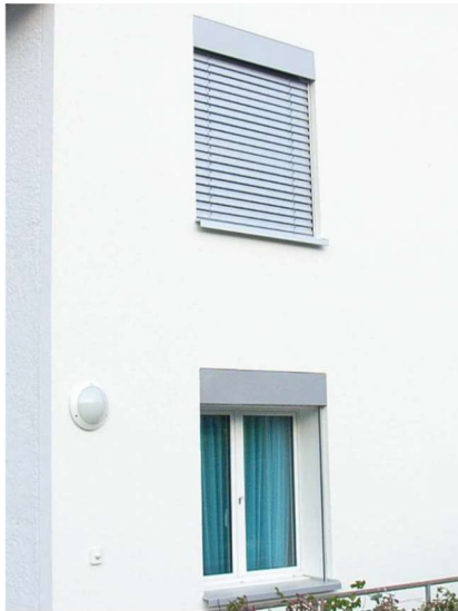
Abbildung 48: Integrierte Lamellenstoren [Quelle: BFE]
