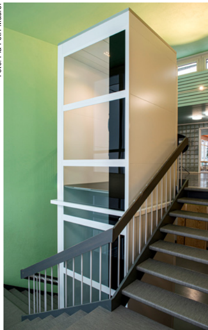
Die neu eingebauten Lifte fügen sich harmonisch in die bestehenden Treppenhäuser ein.
