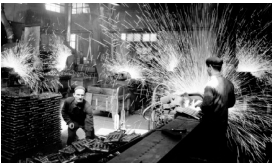
Blick in die industrielle Vergangenheit des Kantons Aargau: Schweissen von Radiatoren um 1939. Foto: Zehnder Group Schweiz AG, Gränichen
