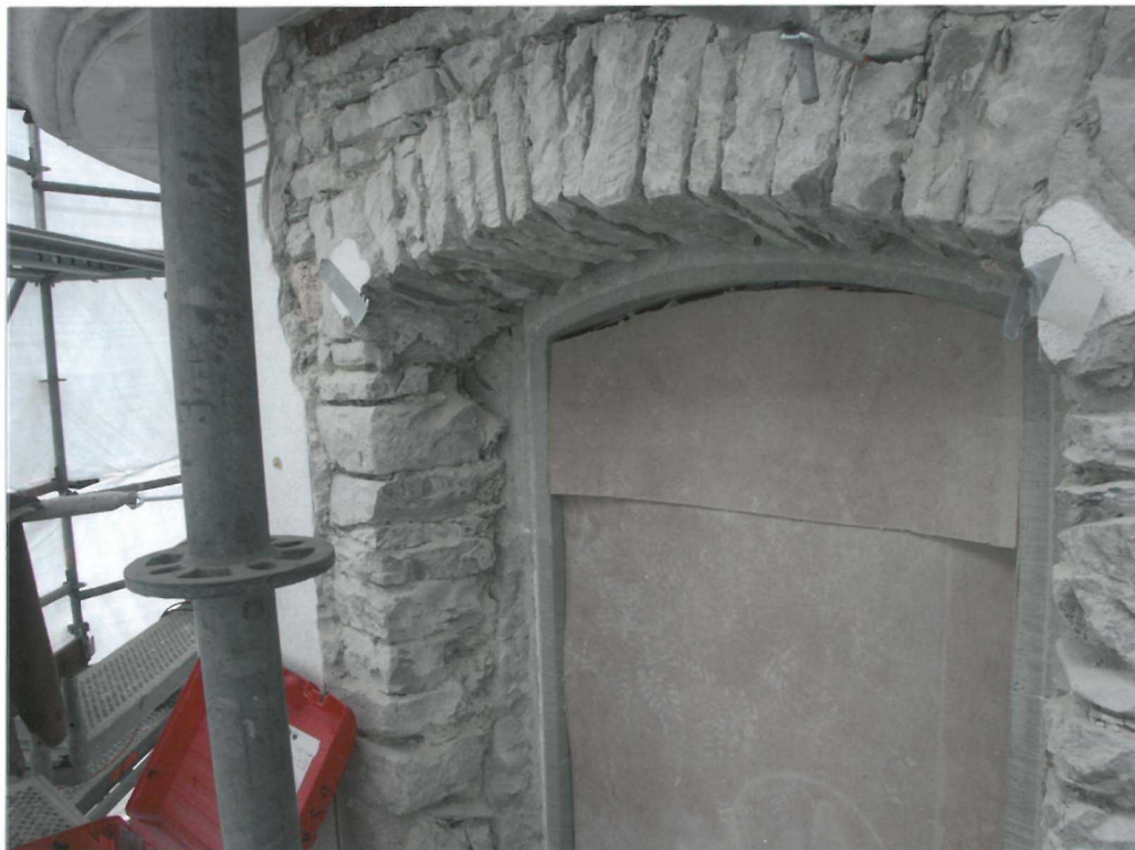
Oben: Aussenbereich; Freigelegtes Türportal Unten: Aussenbereich; Freigelegtes Fenster
