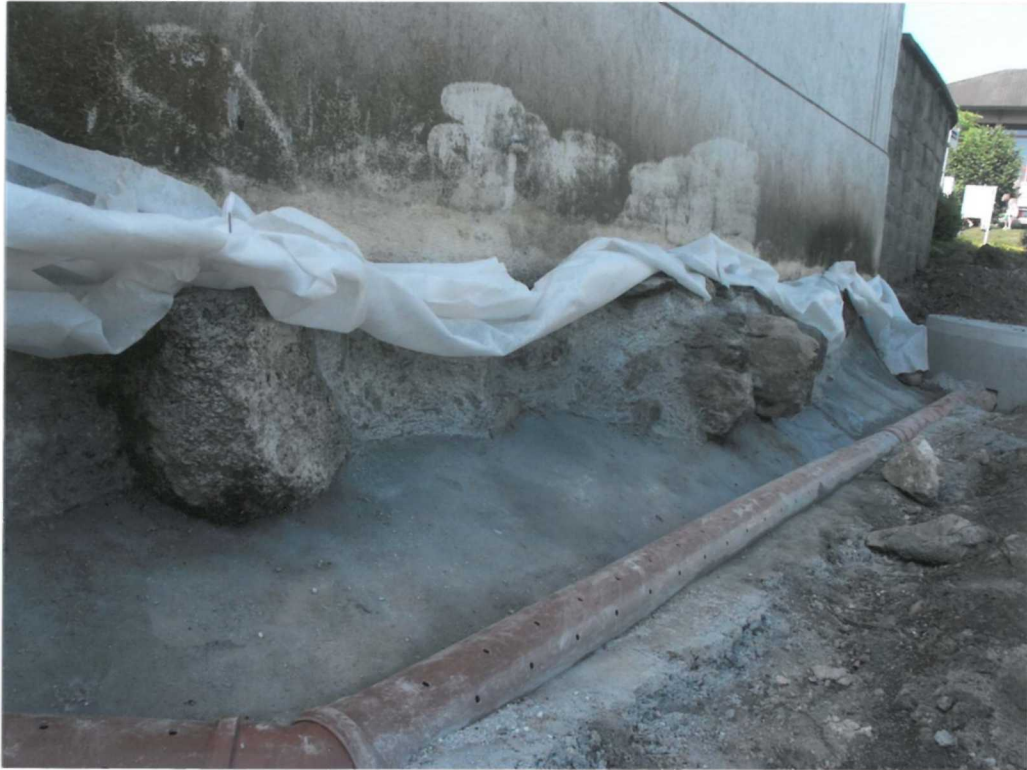
Unten und Oben: Neu gestopftes Unterterrain mit neuer Wasserführung (Sickerleitung)
