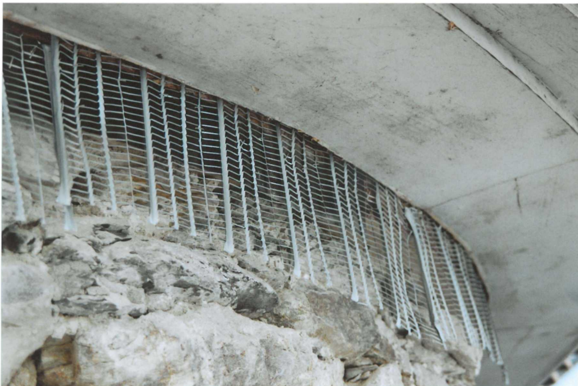
Unten und Oben: Aussenbereich; vom Zementputz freigelegtes Bruchsteinmauerwerk. Holzschwelle auf Mauerkopf wurde mit Dachpappe, Rabitz und Rippenstreckmetall überbrückt.
