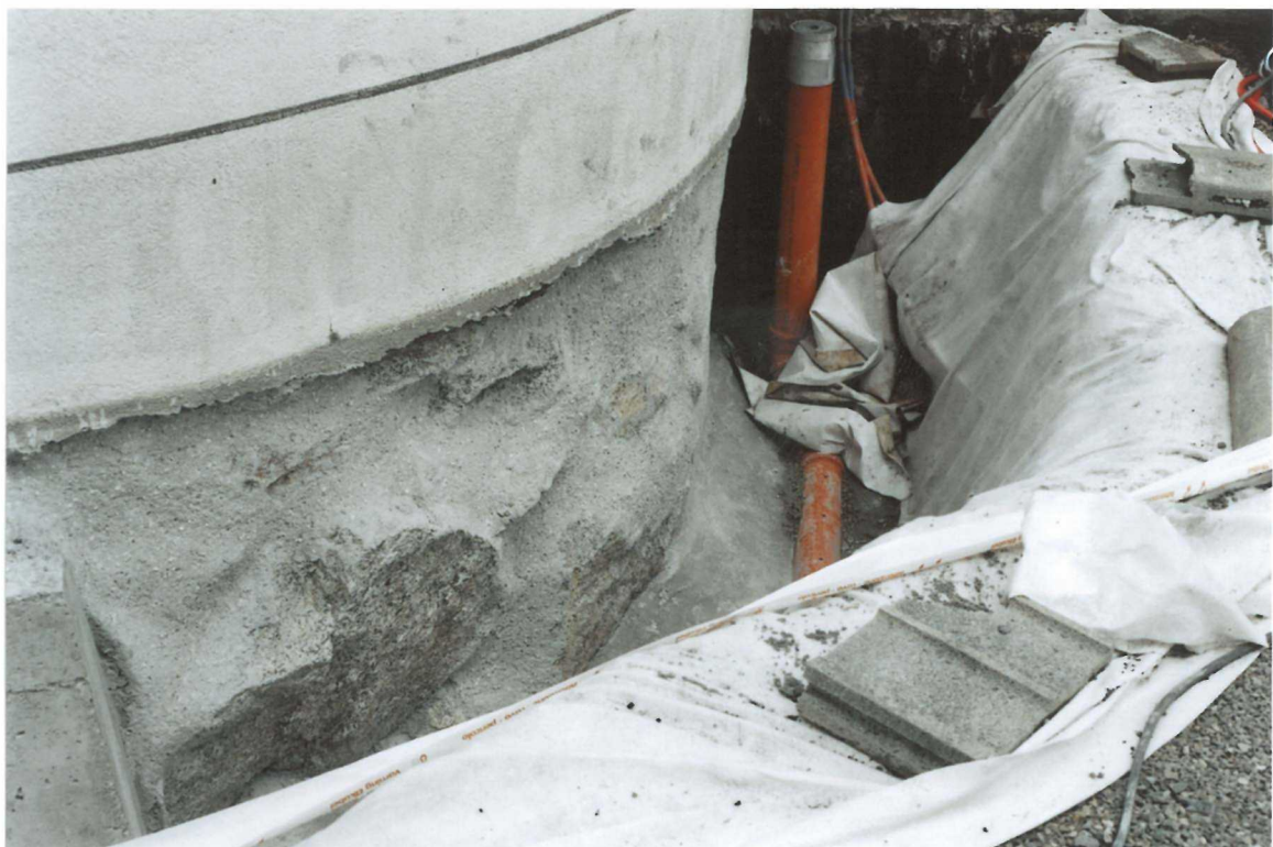
Unten und Oben: Neu gestopftes Unterterrain mit neuer Wasserführung (Sickerleitung)
