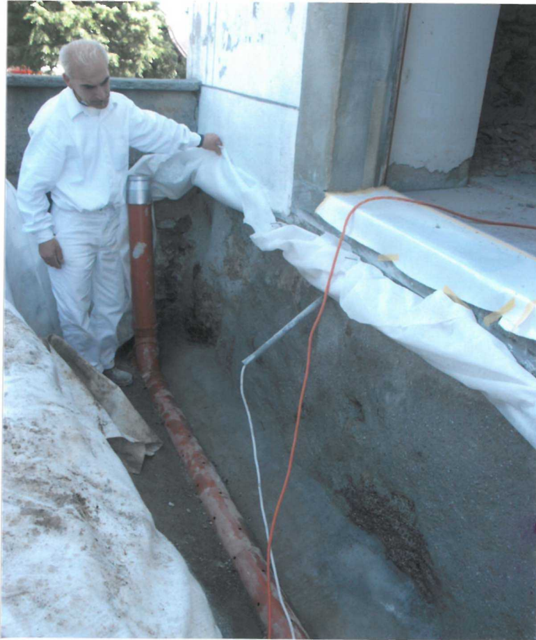
Unten und Oben: Neu gestopftes Unterterrain mit neuer Wasserführung (Sickerleitung)
