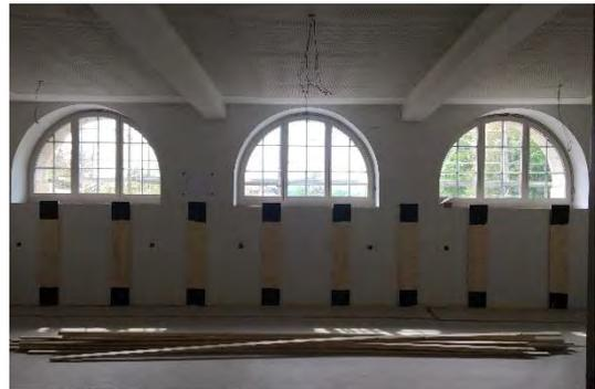
074 Werkraum vor, während Renovation 2017 (Unterkonstruktion für neue Wandbekleidung)
