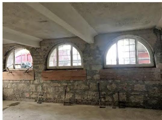
Werkräume während Renovation 2017 (Freigelgtes Mauerwerk, Aufbetonieren Brüstungen)
