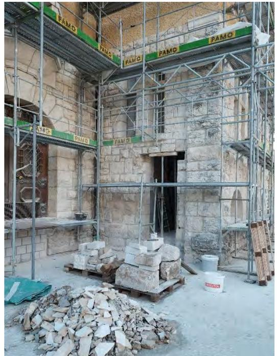
Hoffassade während Renovation 2018 (Fensterschliessung, Türeinbau in Bossenmauerwerk)
