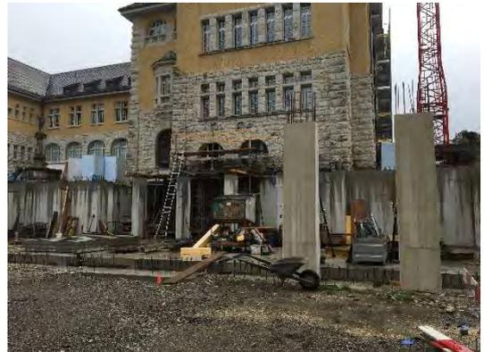
Freilegung und Unterfangung Sockelgeschoss im Bereich der Erweiterung 2017
