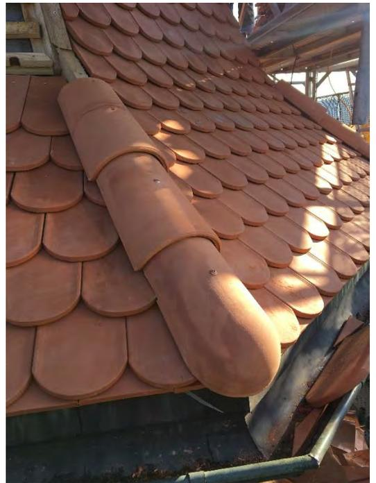
Dach während Renovation 2018 (Dachanschluss an Giebel, Gratziegel Turm ohne Nase)
