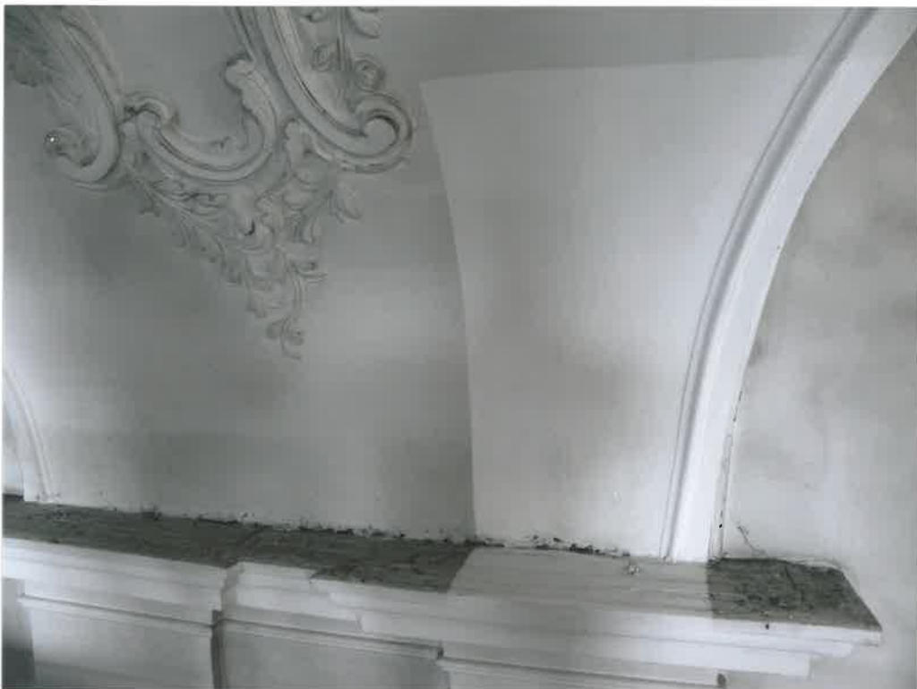
Oben und unten: Bemusterung: Russpatina in Trockenreinigungsverfahren entfernen.
