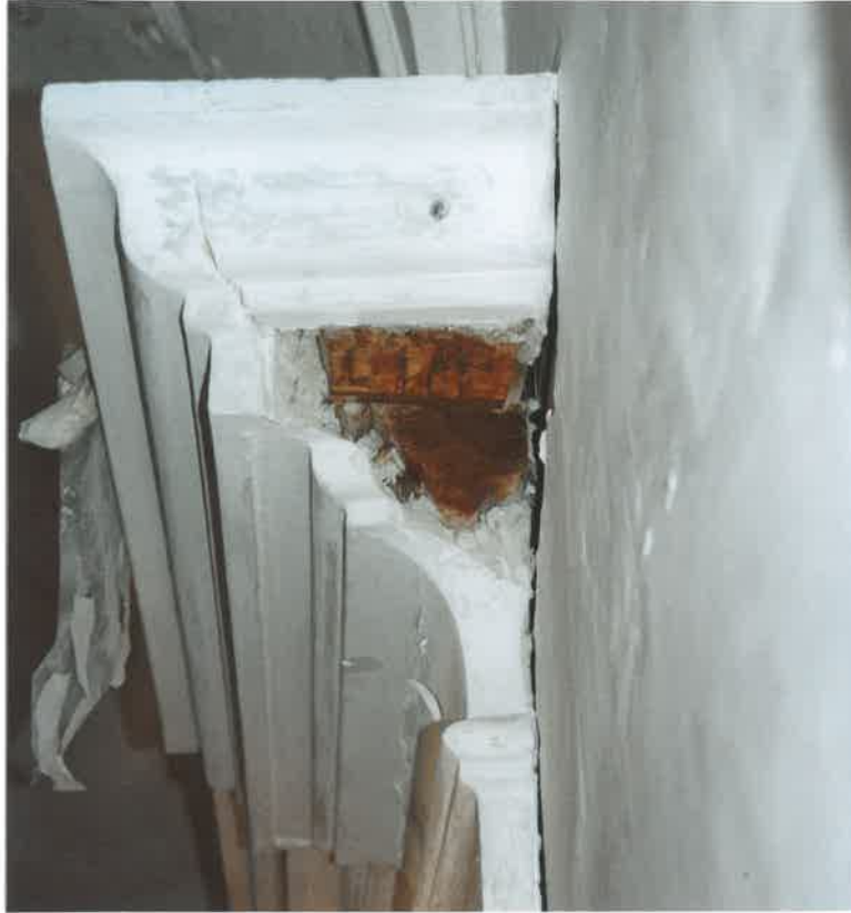
Oben: Lose Stuckpartie am Kämpfergesimse wurde ausgebaut und neu angemörtelt. Unten: Lose Putzflächen wurden ausgebaut und neu verputzt.
