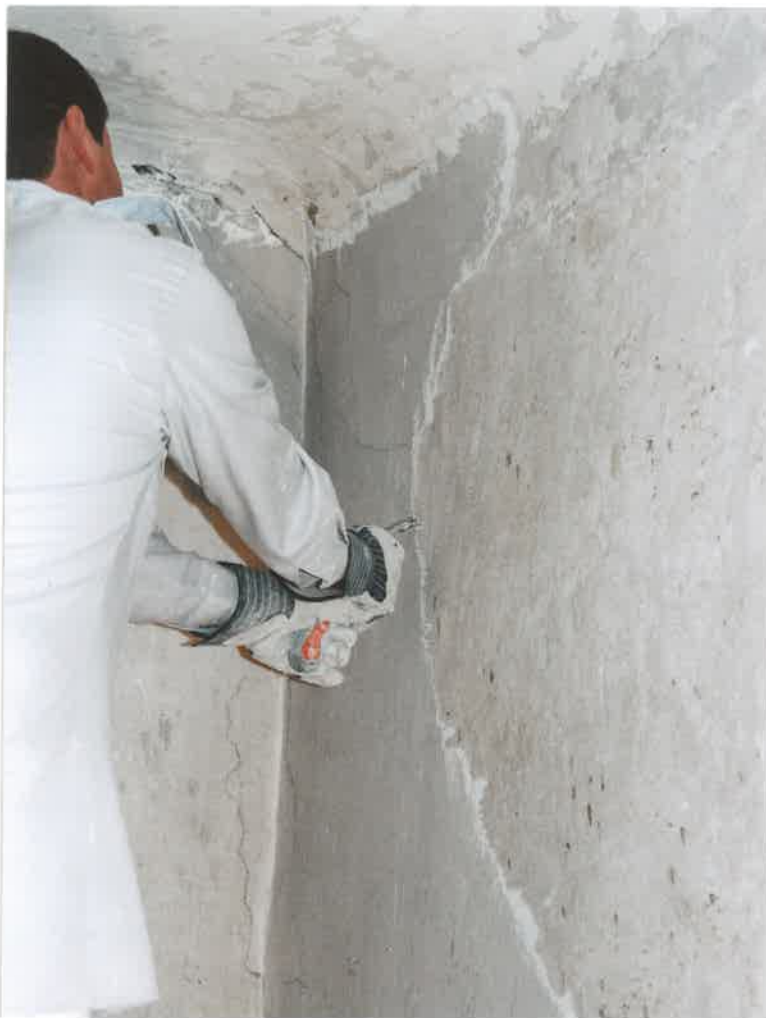
Oben: Wandflächen werden mechanisch freigelegt. Unten: Freigelegte Stuckkartusche.
