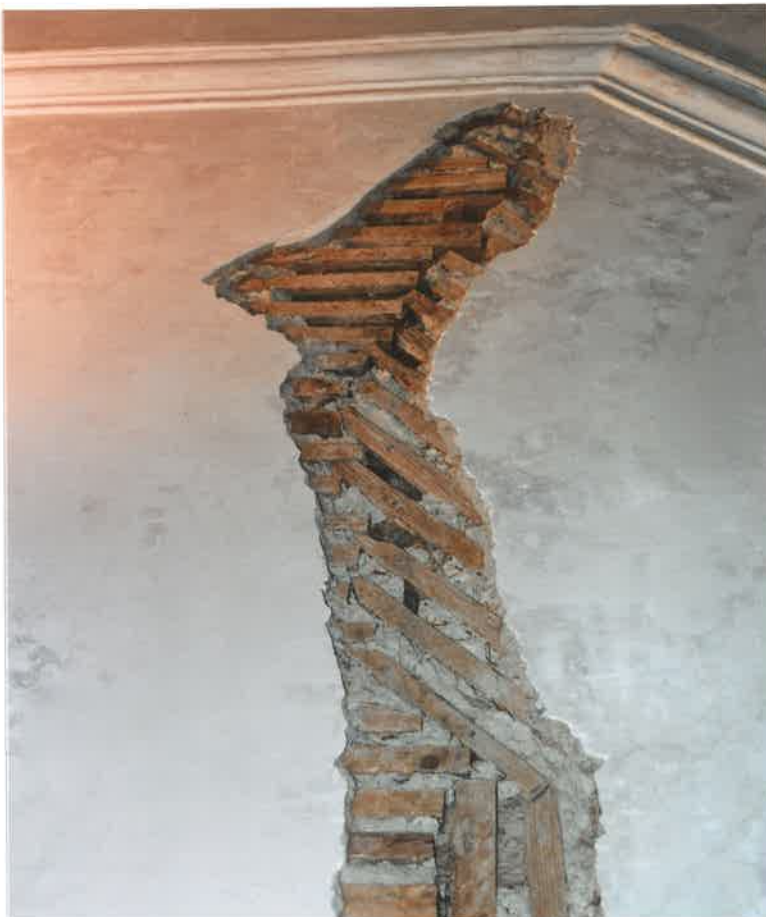
Oben und unten: Nicht überlappende Trägerlattenstösse führten zu statischen Rissen.
