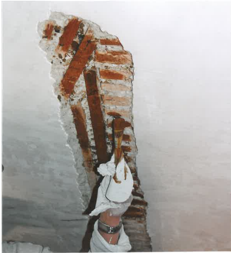
Oben und unten: Nicht überlappende Trägerlattenstösse führten zu statischen Rissen.
