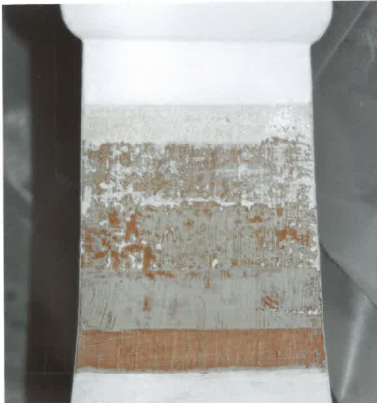
Oben: Reinigungsschnitt am Gewölbe. Unten: Chor: Fassungschnitt an den Balustern Chorempore.
