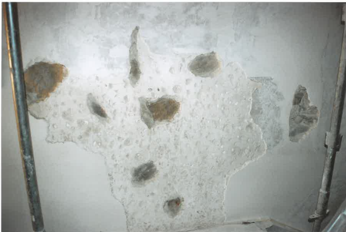
Oben: Lose Stuckpartie am Kämpfergesimse wurde ausgebaut und neu angemörtelt. Unten: Lose Putzflächen wurden ausgebaut und neu verputzt.
