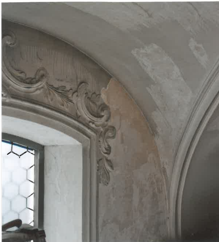
Oben: Während den Freilegungsarbeiten. Unten: Chor: Lose Putzpartien wurden abgestossen. Darunter ist der alte, mit Schwundrissen versehene Originalputz deutlich sichtbar.
