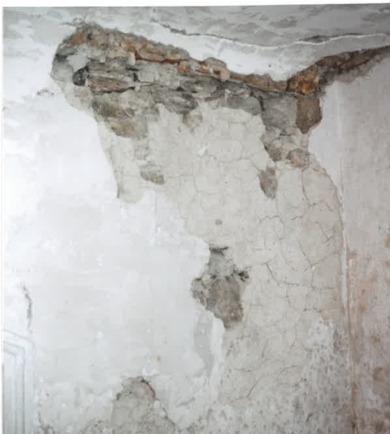
Oben: Während den Freilegungsarbeiten. Unten: Chor: Lose Putzpartien wurden abgestossen. Darunter ist der alte, mit Schwundrissen versehene Originalputz deutlich sichtbar.
