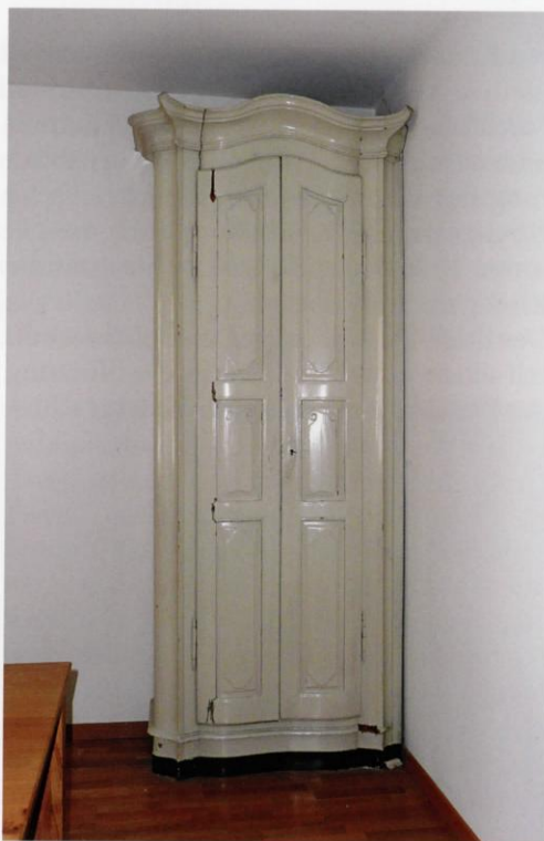
Abb. 4 Von der bauzeitlichen spätbarocken Ausstattung hat sich im Erdgeschoss ein schlanker, zweitüriger Kasten mit geschweiftem Gebälk erhalten.
