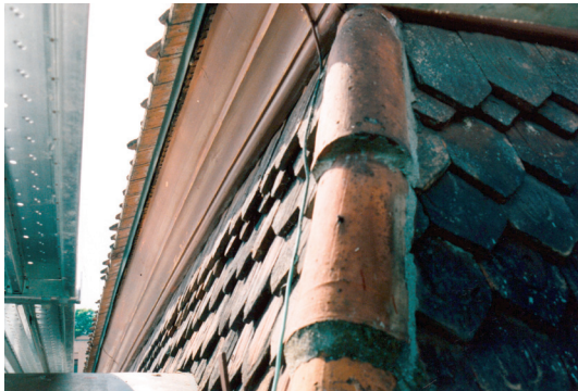
Abb. 6: Detailaufnahme Dachbruchbereich, Nachzustand mit eingemörtelten Gratziegeln und Abtropfblech oberhalb der Holzabschlüsse. Foto: Castor Huser, Baden
