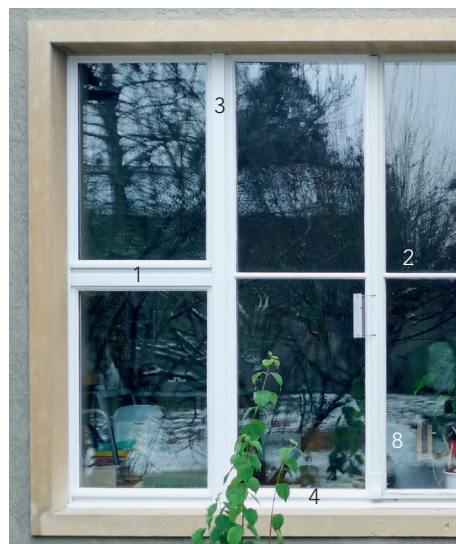
Abb. 7: Musterfenster. Ersatz der linken und mittleren Innengläser durch innere IV-Vergrasung.
