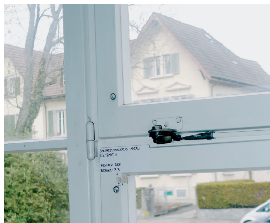
Abb. 2: Restauratorische Farbumtersuchung. Trakt 1, Erdgeschoss, Erschliessungsbereich.
