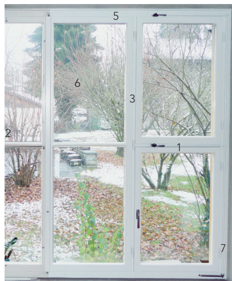
Abb. 8: Musterfenster. Bei rechtem und mittlerem Flügel sind die Innenscheiben durch IV-Vergrasung ersetzt. Trakt 1, Ostfassade, EG
