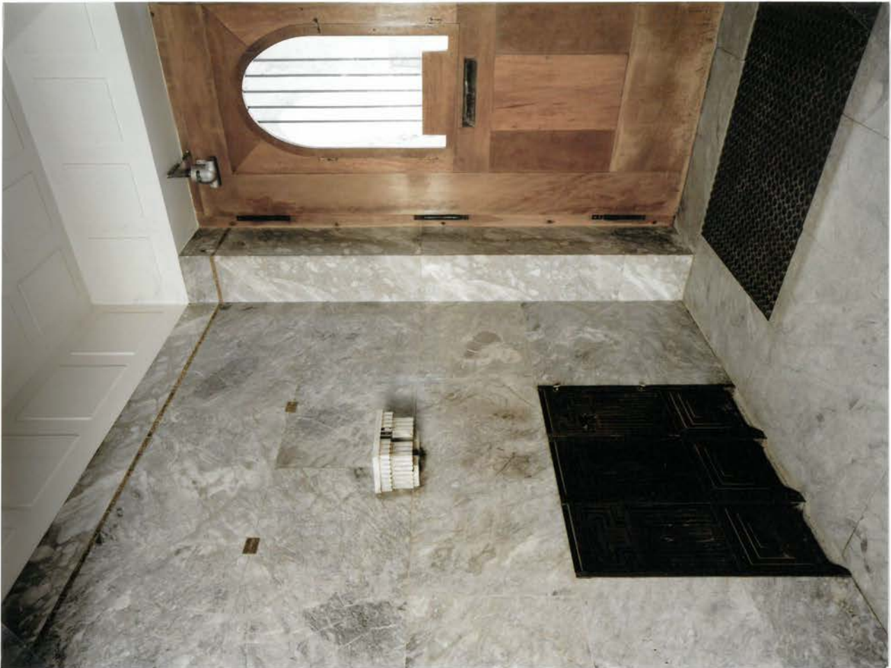
EG - Vorraum (Raum 111, Bild 111.1)
