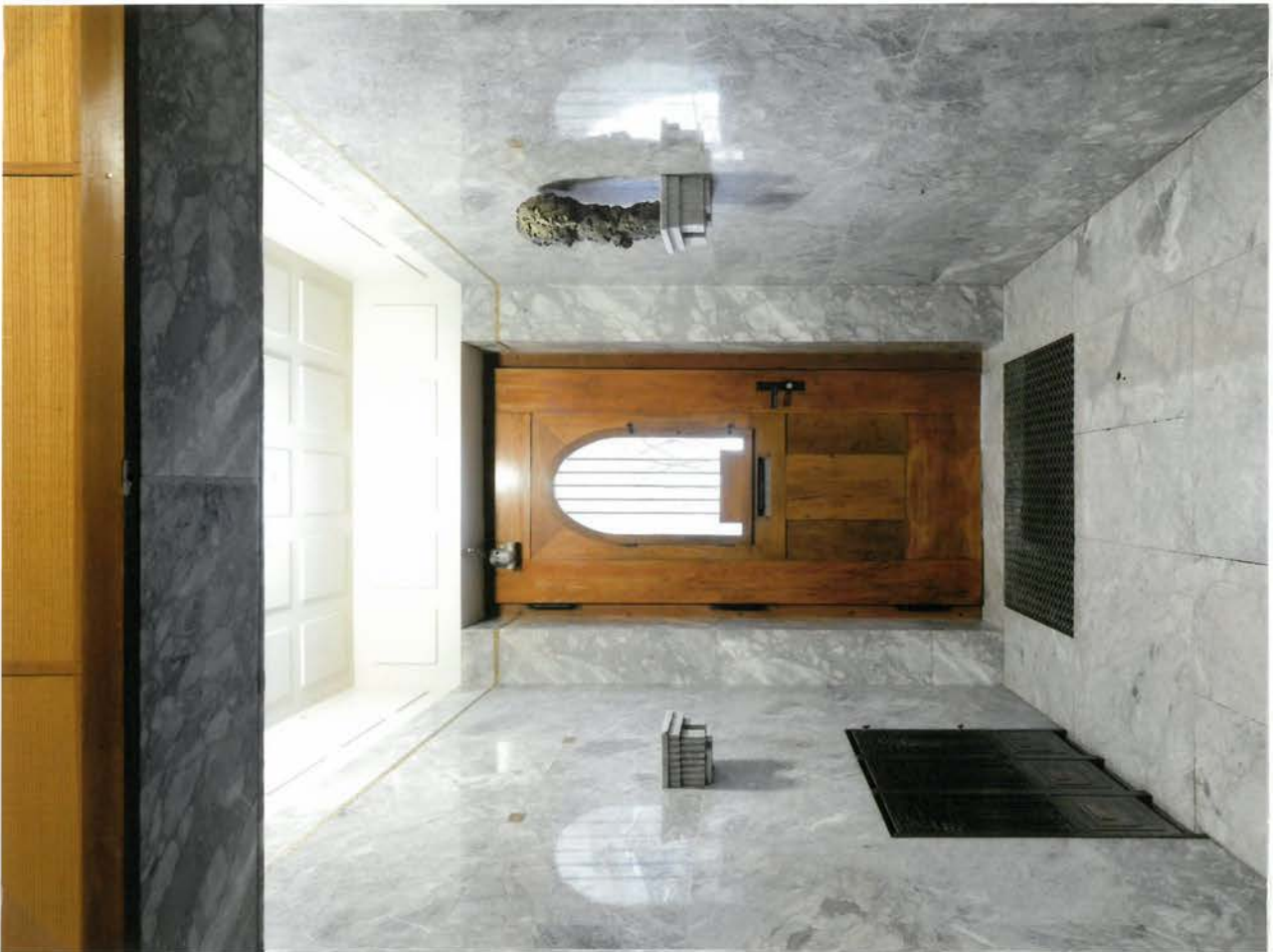
EG - Vorraum (Raum 111, Bild 111.1)
