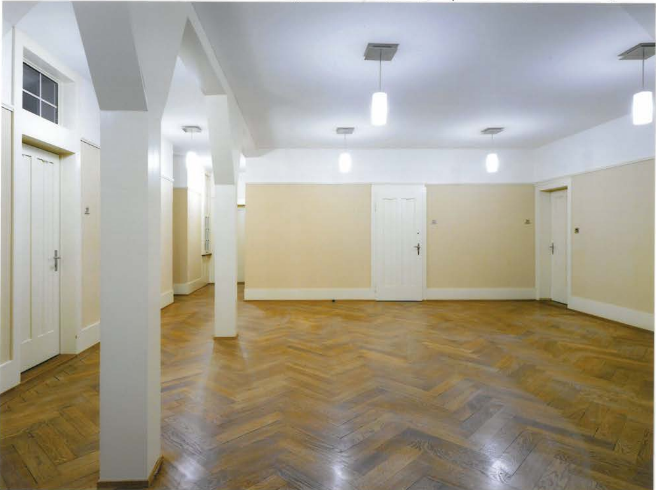
DG - Halle und Stichkorridore (Raum 314, Bild 314.1)
