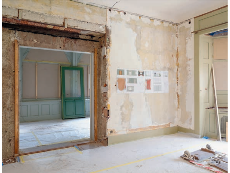
Früheres Wohnzimmer: Blick zur Veranda durch die demontierte Türe mit Vitrinen
