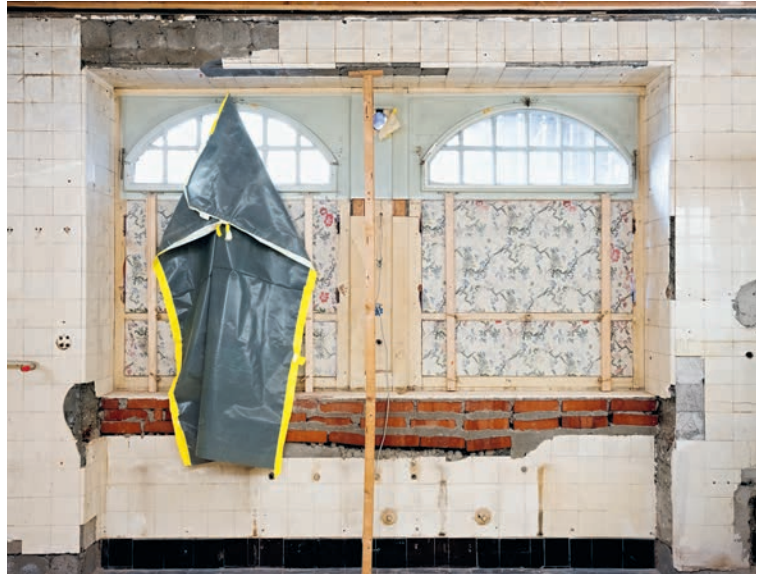
Küche: wiederentdeckte grosszügige Fensteröffnungen, provisorisch mit tapezierten Brettern verschlossen
