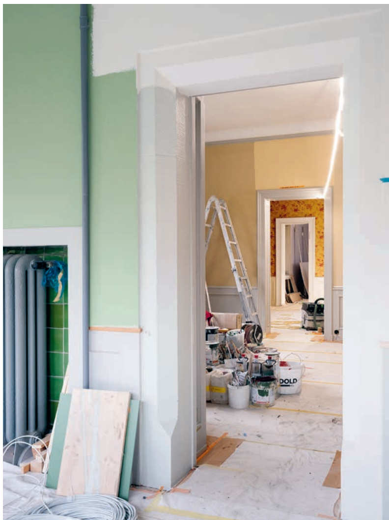
Veranda: Blick in die früheren Privaträume im Obergeschoss mit diversen Farbbemusterungen
