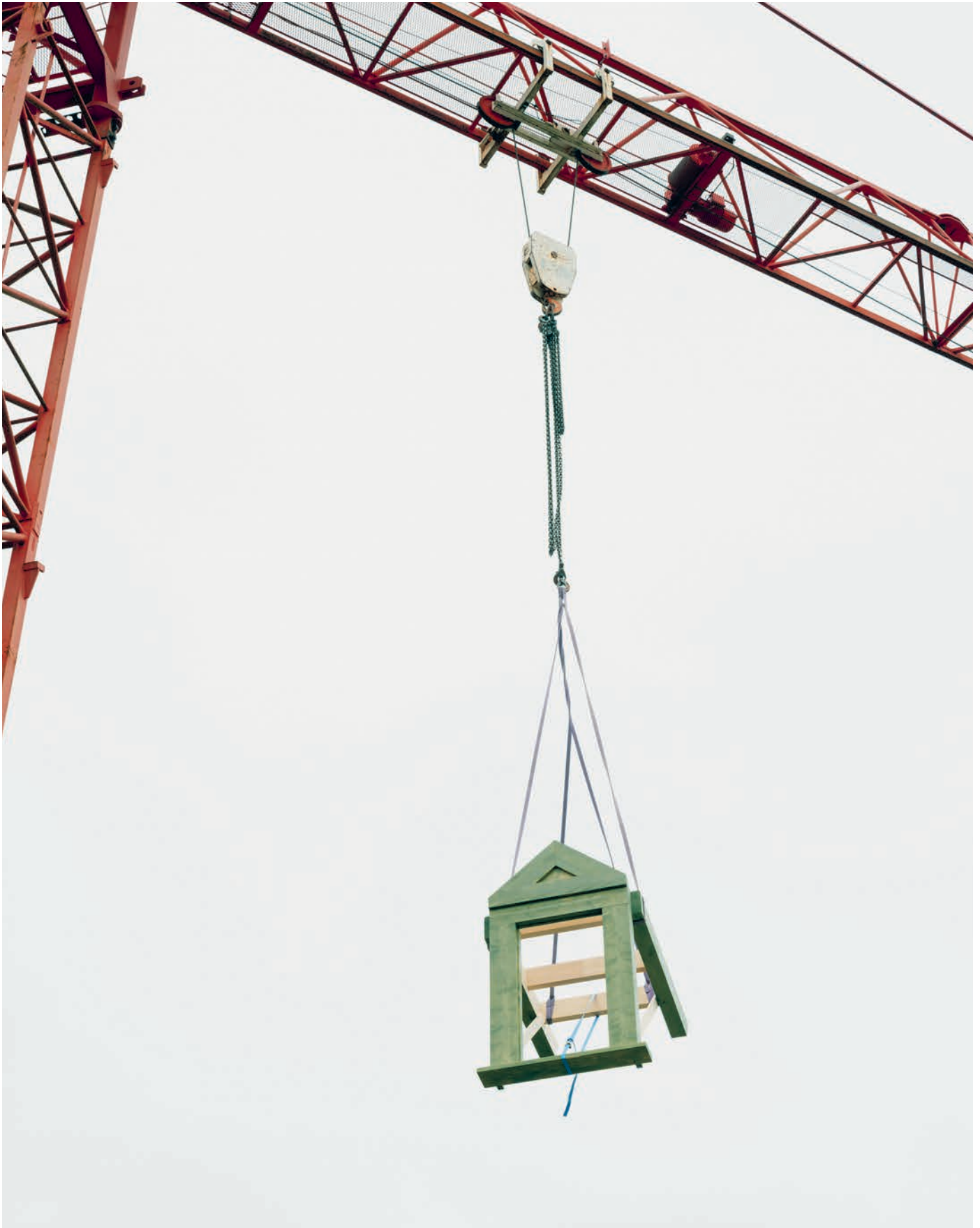
«Lieferung» der rekonstruierten Dachlukarne des Badezimmers im Dachgeschoss
