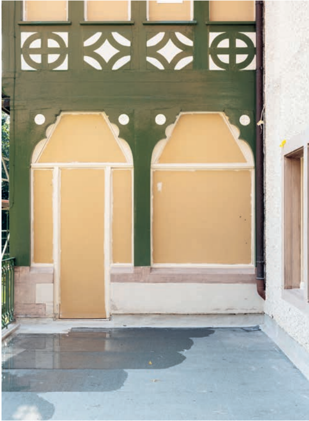
Verandaanbau: Fachwerk mit den provisorisch ausgebauten und verschlossenen Fenstern
