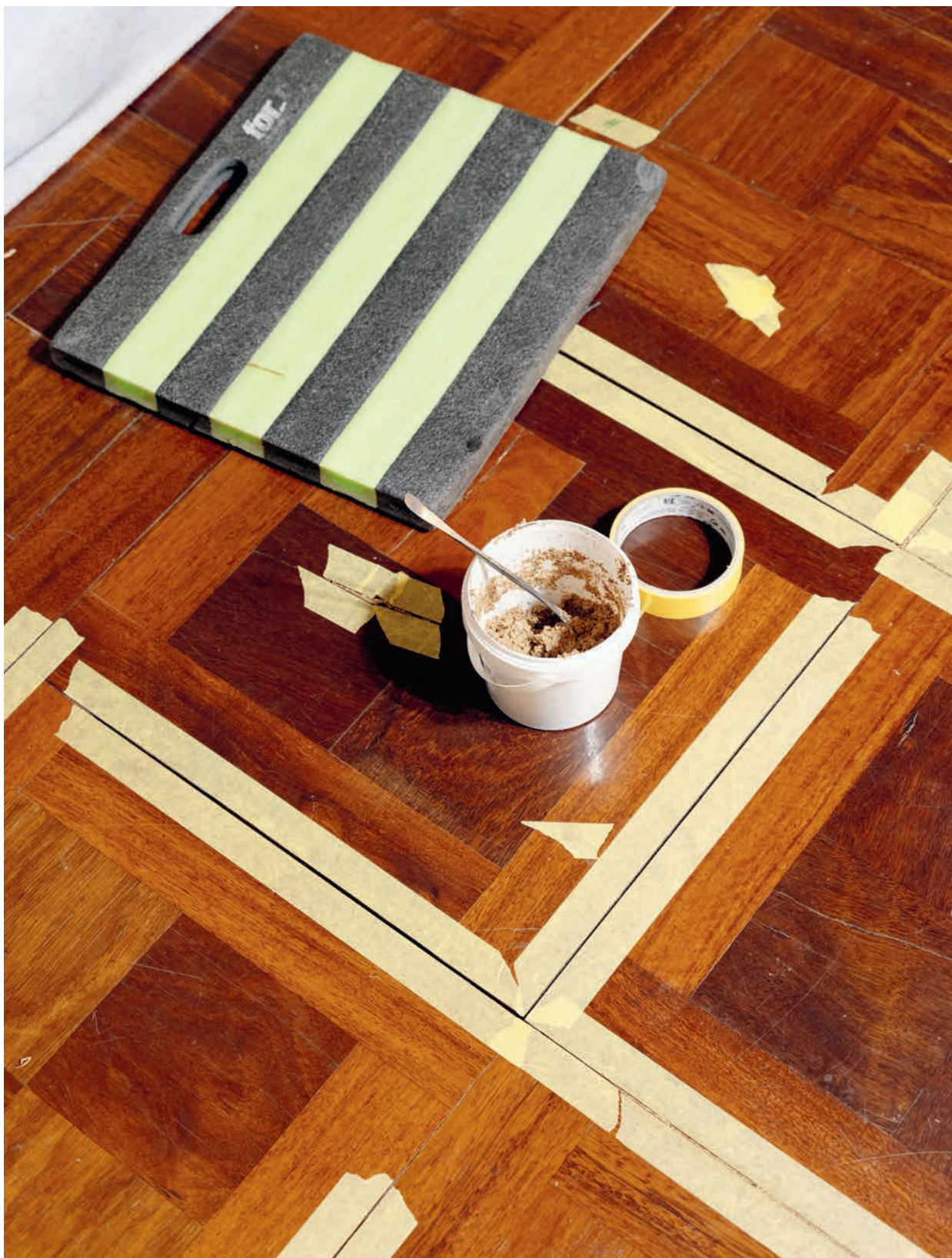
Galerie: Restaurierungsarbeiten am originalen Mahagoni-Parkett von 1906
