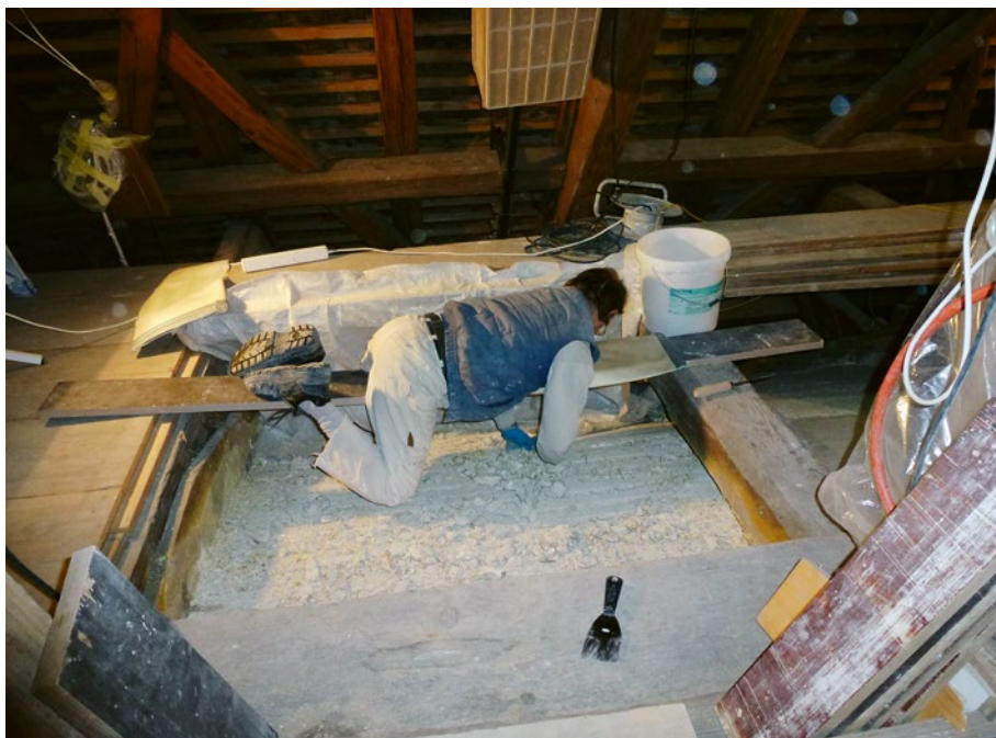
10 Kaiserstuhl, röm.-kath. Pfarrkirche St. Katharina. Der teilweise Absturz des barocken Deckengewölbes 2012 zog umfassende Konservierungsmassnahmen nach sich. Die Putzlattenkonstruktion der Gipstonne über dem Kirchenschiff wurde vom Dach aus gesichert (Foto: © Kantonale Denkmalpflege Aargau, 2012).
