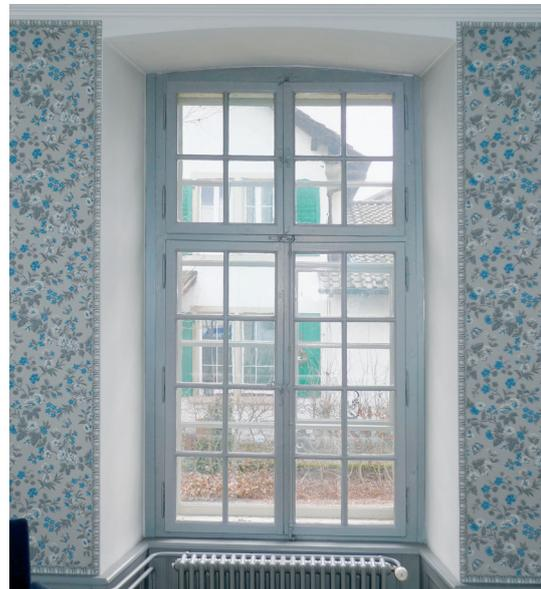
Abb. 2: Konserviertes Innenfenster. Südfassade, Erdgeschoss, Raum Nr. 11.
