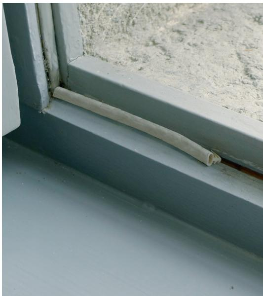
Abb. 5: Eingefräste Dichtungen bei den Innenfenster-
