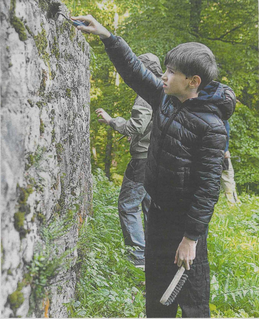
Das Moos an den Seitenwänden des Fundaments des ehemaligen Wohnturms wird mit einer Dreieckskeile entfernt.
