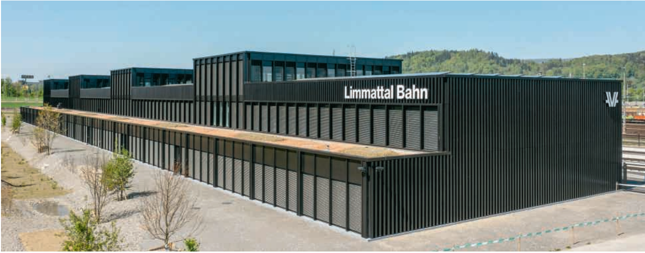
Das Depot der LTB ist 145 Meter lang und steht auf Dietiker Boden
