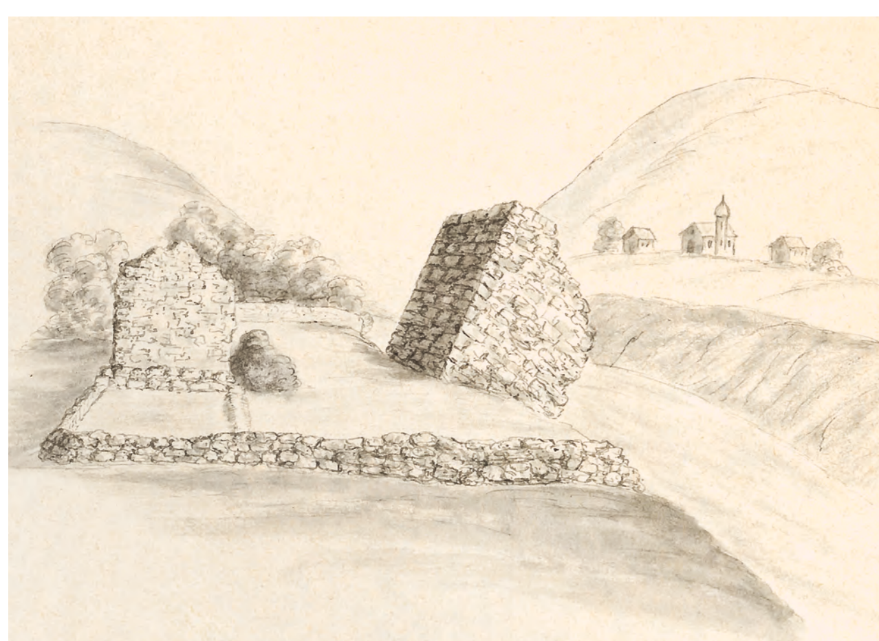
Der stark unterspülte Turm kurz vor der Sprengung, die Ringmauer und die Überreste des Palas (Zentralbibliothek Zürich, Graphische Sammlung und Fotoarchiv).
