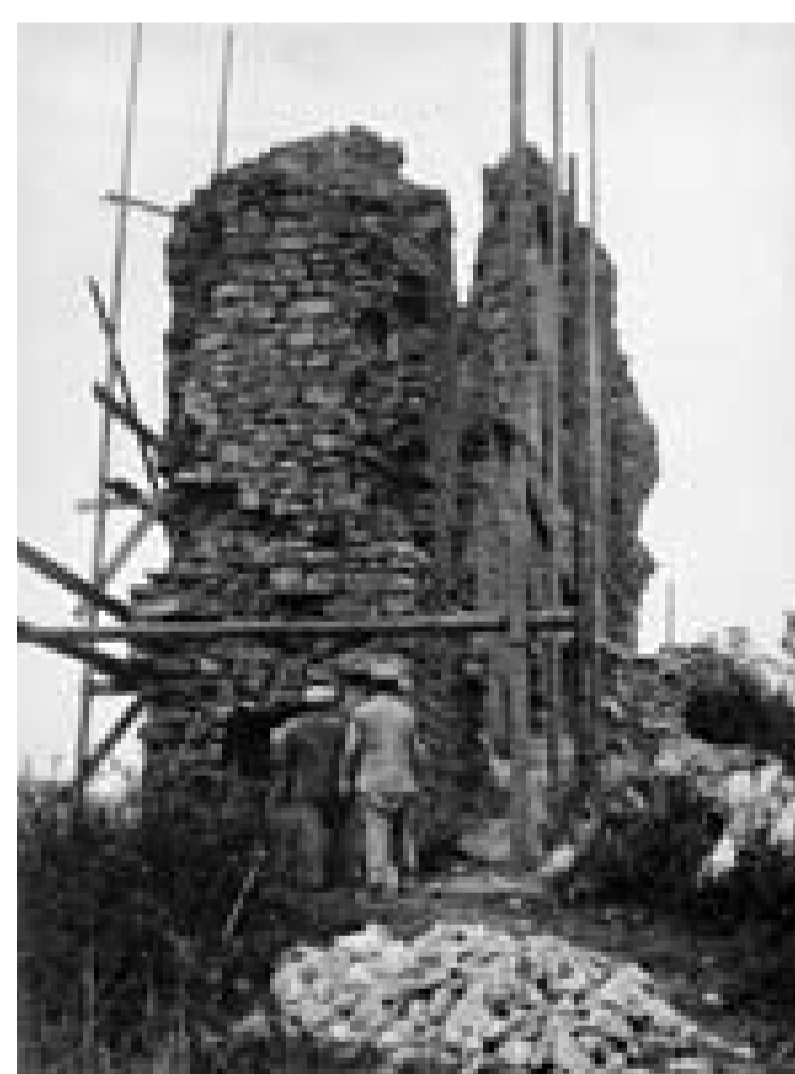
Die eingerüstete Schildmauer während der Sanierung 1931.
