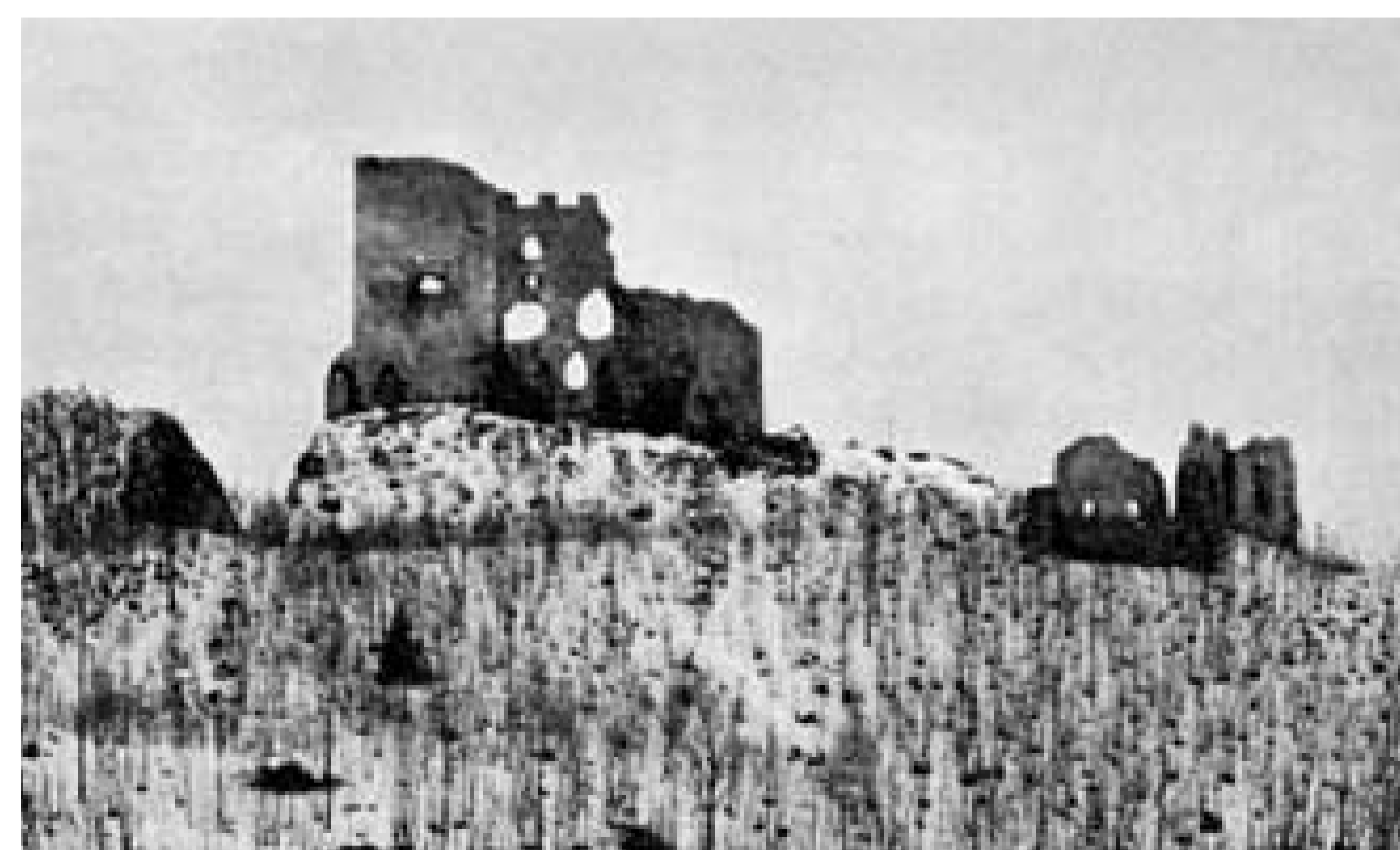
Schenkenberg von Norden um 1885. Teile des Hauptturmes sowie der Schildmauer mit den Ausbrüchen ehemaliger Maueröffnungen sind noch erhalten. Der rasante Zerfall der Anlage führte im Jahre 1919 zu ersten Sanierungsarbeiten.
