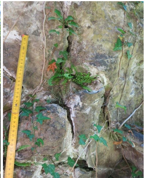
Anwitterungsfläche des Kieselkalkes
