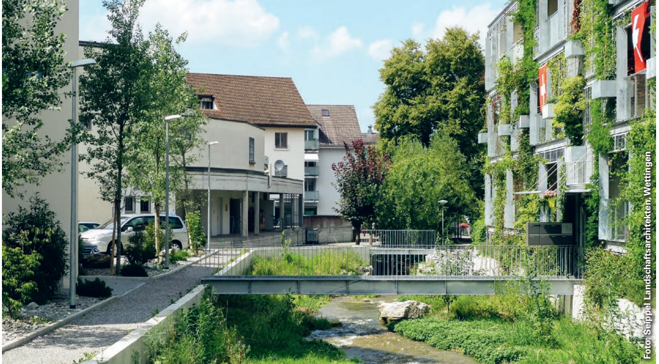
Fassadenbegrünung, offene Wasserflächen mit viel Grünraum und Bäume sorgen hier am Erusbach in Villmergen für ein hohes Kühlpotenzial im Siedlungsraum.
