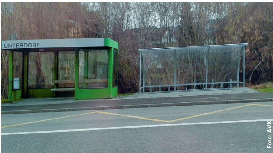
Auch bei Bushaltestellen können geeignete Veloabstellplätze zur Verfügung gestellt werden, Haltestelle Ehrendingen Unterdorf.
