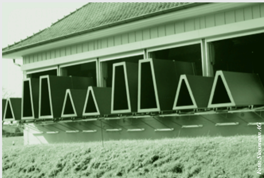
Schallschutztunnel für Kniend- und Liegend-Schiessen
